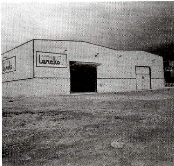
Instalaciones de Laneko, en Uharte Arakil.
